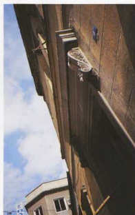
17. Το γείσο και οι παρωτίδες των θυρωμάτων, πιστά αντίγραφα των παρωτίδων των θυρωμάτων της βόρειας στοάς του Ερεχθείου. Σημερινή κατάσταση.
