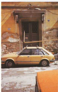
16. Η κεντρική εξώθυρα με κατώφλι, πλαίσιο και γείσο από λευκό μάρμαρο. Σημερινή κατάσταση.
