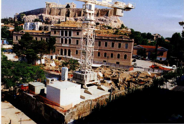
Οικοδομικό τετράγωνο Μακρυγιάννη. Μπροστά στο κτήριο Weller το εργοτάξιο του ΜΕΤΡΟ και των αρχαιολογικών ανασκαφών, από τα ναπολεονατολικά.
