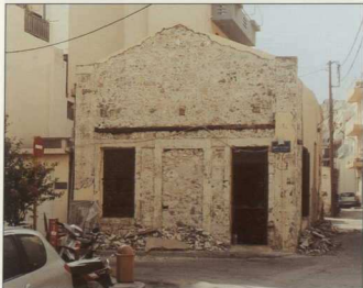
1. Η ιδιοκτησία Παπουτσάκη, στη γωνία των οδών Γρεβενών και Γάδ, πριν από την καθαίρεση των κονιαμάτων. Διακρίνεται το πλάτος του παλαιού τμήματος της οδού Γρεβενών και η νέα οικοδομική γραμμή υπολοίπων στην πολυκατοικία πίσω από την ισόγειο οικία.
